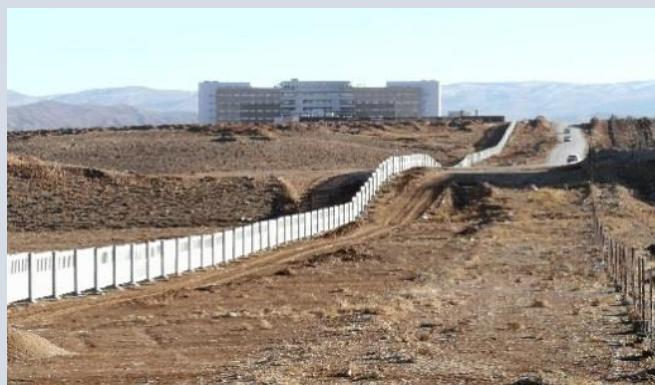
◀ دیوار تیپ ۲ - دورو نما ( طرح محرابی ) - ارتفاع: ۲ متر، طول دهانه: ۳/۱۷ متر، ضخامت پنل: ۱۰ سانتی متر - مسلح
