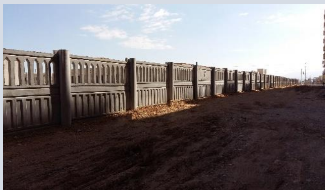
◀ دیوار تیپ ۲ - دورو نما ( طرح محرابی ) - ارتفاع: ۲ متر، طول دهانه: ۳/۱۷ متر، ضخامت پنل: ۱۰ سانتی متر - مسلح
