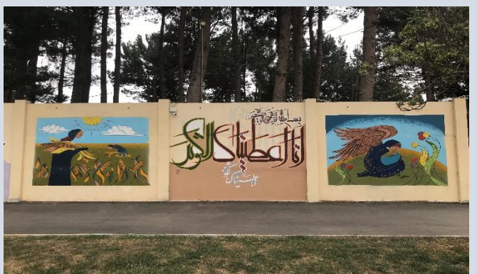
◀ دیوار تیپ ۳ - دورونما - ارتفاع: ۳/۶ متر، طول دهانه: ۴/۱۲۵ متر، ضخامت پنل: ۱۰ سانتی متر - مسلح
